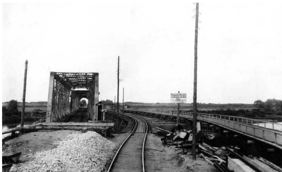
Tymczasowa przeprawa kolejowa i kładka przez rzekę Bug omijająca uszkodzoną konstrukcję mostu (domena publiczna)
