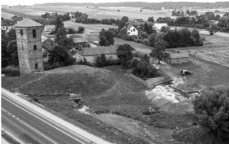
Fot. 17. Widok z drona na zespół wieżowy z wykopami 41 i 42. Fot. Ł. Staśkiewicz
