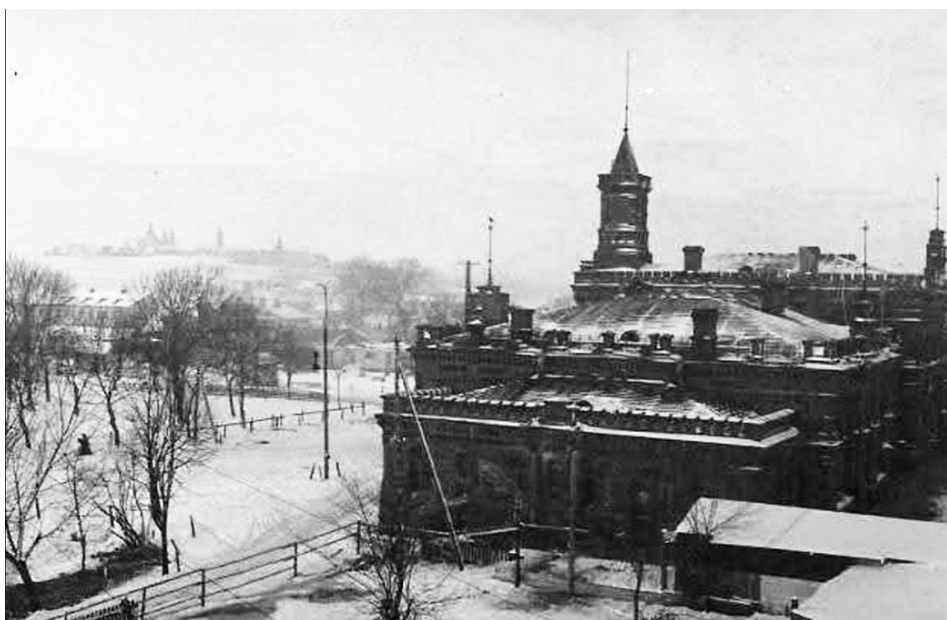
Budynek dworcowy w Chełmie, widok od strony północno-wschodniej.
