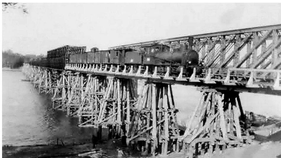
Przejazd pociągu towarowego przez tymczasową przeprawę na rzece Bug w Dorohusku (domena publiczna)
