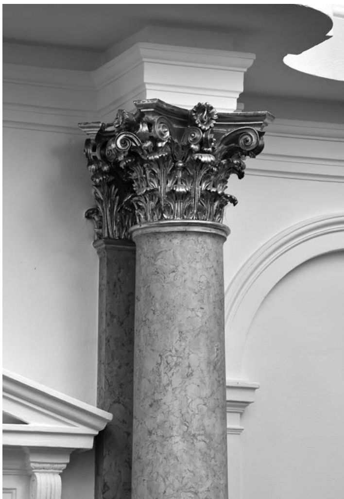
Bazylika Narodzenia NMP w Chełmie. Wnętrze. Fragment kolumny podtrzymującej empore z organami
