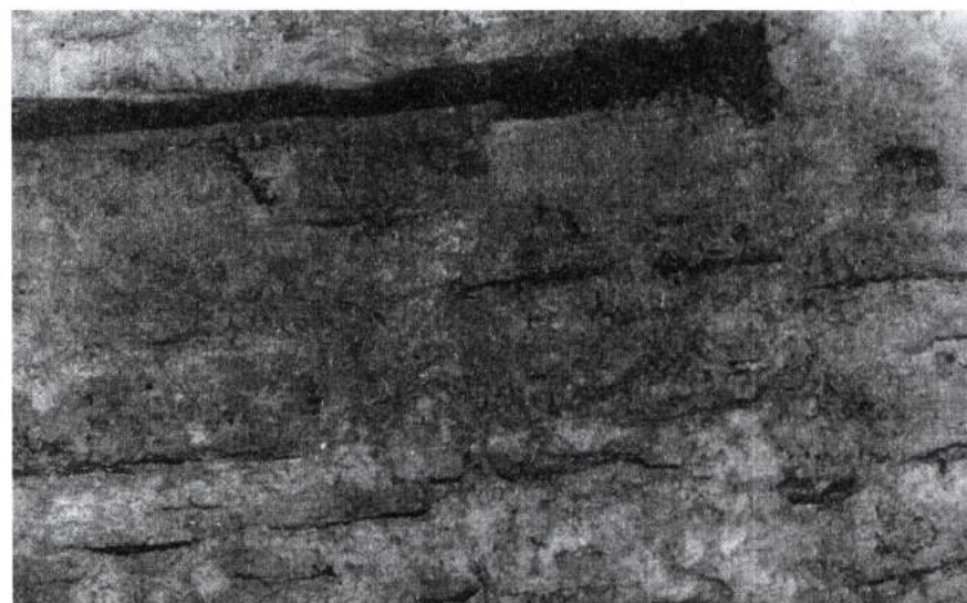
Ryc. 6. Pozostałości tzw. konstrukcji górniczej — deski pomostów (fot. G. Mazur)
