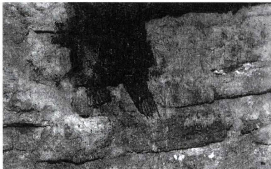
Ryc. 5. Pozostałości tzw. konstrukcji górniczej — osadzenie belki konstrukcyjnej jednego z pomostów
