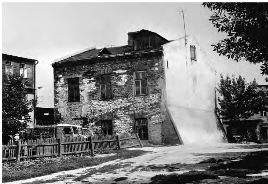
Fot. 2. Chełm, ul. Przechodnia. Widok od południa po rozebraniu kamienicy. Fotografia z 1967 r. (archiwum Wojewódzkiego Urzędu Ochrony Zabytków w Lublinie Delegatury w Chełmie)
