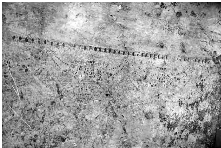
Fot. 7. Chełm, ul. Przechodnia. Wnętrze piwnicy po odkryciu. Tynk pokryty kilkoma warstwami farby. Fot. S. Gołub
