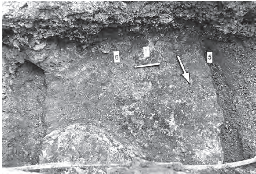
Fot. 7. Chełm, ul. Lubelska 55. Wykop ciepłowniczy (1996). Fragment zachodniego muru fundamentowego (nr 2) nieokreślonej budowli (renesansowego kościoła?). Foto G. Zabłocki
