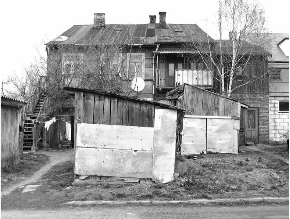
Wojślawice – zaplecze drewnianych kamienic na południowej pierzei rynku, kwiecień 2004 r.
