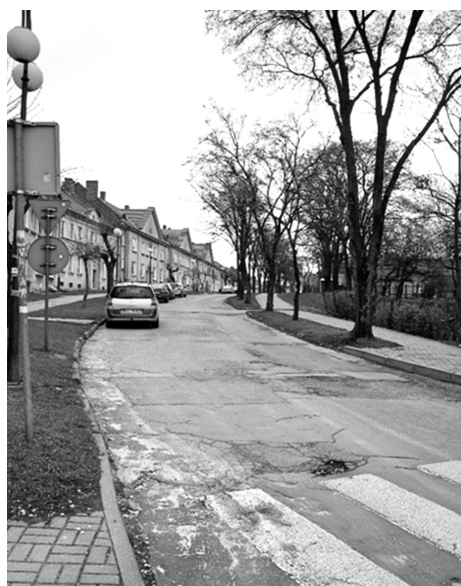
Fot. 4. i fot. 5. Ulica Bydgoska wymagająca wymiany nawierzchni; Uliczka dojazdowa przy bloku na al. Piłsudskiego (fot. E. Kiszowara, 2016)
