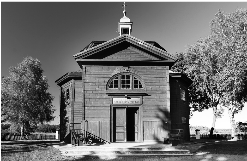
Fot. 1. Elewacja frontowa kościoła, widok od strony południowej (fot. S. Rudnik, 2011)
