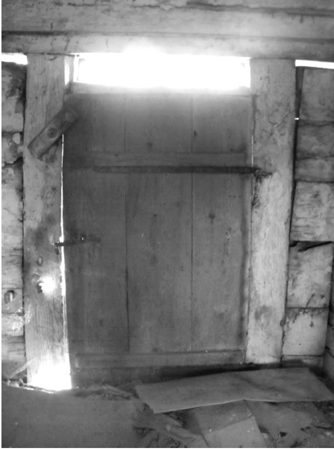
Drzwi sponowe z drewnianą zasuwą
