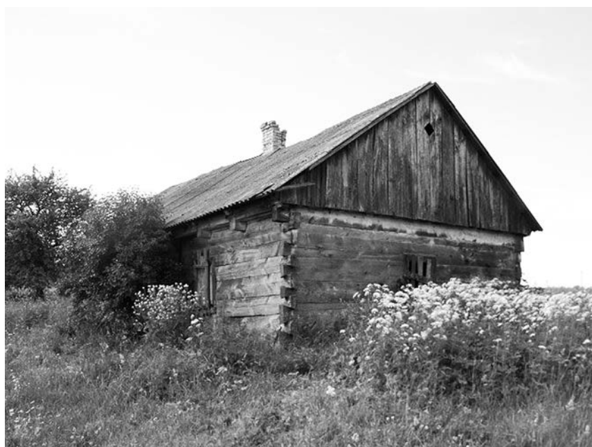
Widok od strony podwórza
