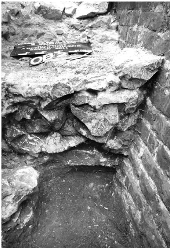
Ryc. 11. Przypora południowa (ob. 2). Zbliżenie na „dostawienie” przypory do ściany kościoła (fot. N. Jędruszczak)
