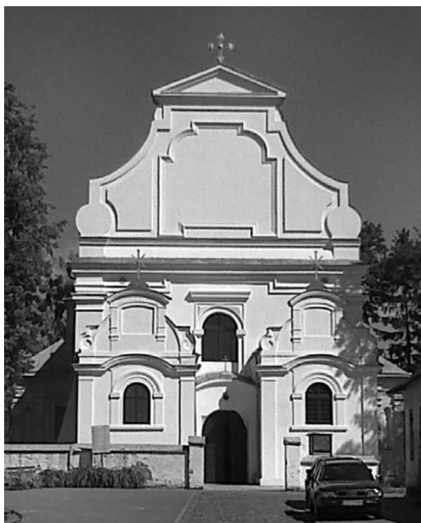
Ryc. 1. Wejście do Kościoła pw. św. Michała Archanioła w Wojsławicach. Stan z roku 2014 (fot. N. Jędruszczak)
