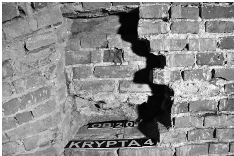
Fot. 15. Fragment wewnętrznego południowego muru cerkwi z XIII wieku za ścianą krypty 4 (odkrywka architektoniczna)
