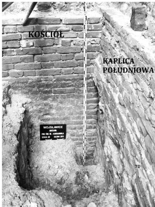
Ryc. 4. Styk murów kościoła i dobudowanej kaplicy południowej (fot. T. Dzieńkowski)
