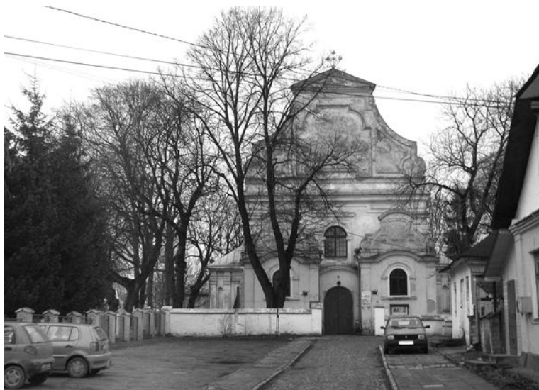
Fot. 1. Wojsławice, kościół, wygląd elewacji frontowej przed remontem Fot. S. Rudnik, 2009 r.
