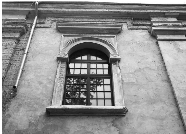
Fot. 3. Fragment elewacji bocznej podczas prac remontowych Fot. S. Rudnik, 2012 r.
