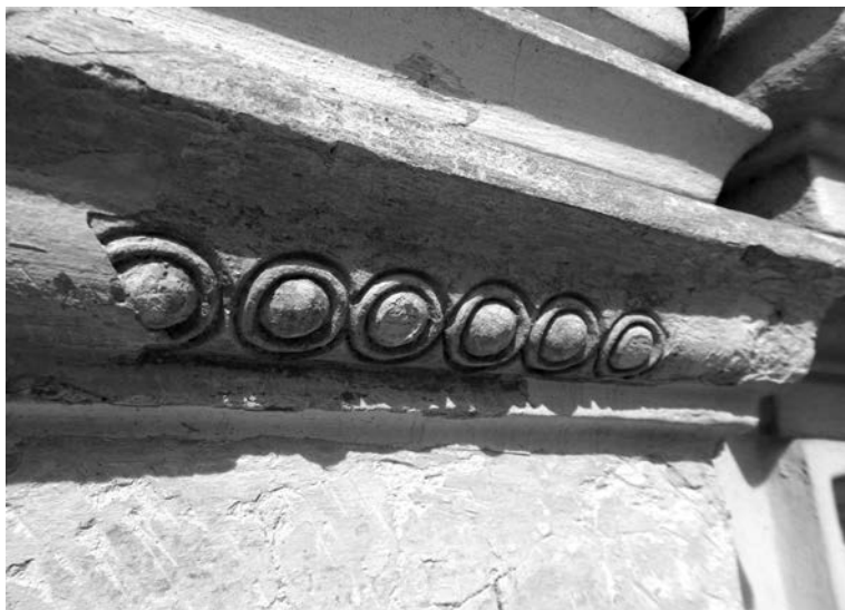
Fot. 6. Elementy dekoracyjnego gzymsu odsłonięte w trakcie prac konserwatorskich przy detalu architektonicznym Fot. S. Rudnik, 2014 r.
