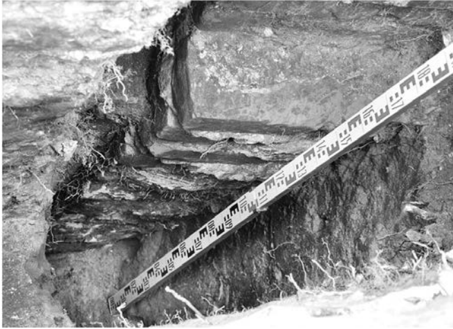
Ryc. 8. Widok na fundamentowanie zakrystii (narożnik północno-wschodni) (fot. S. Gołub)
