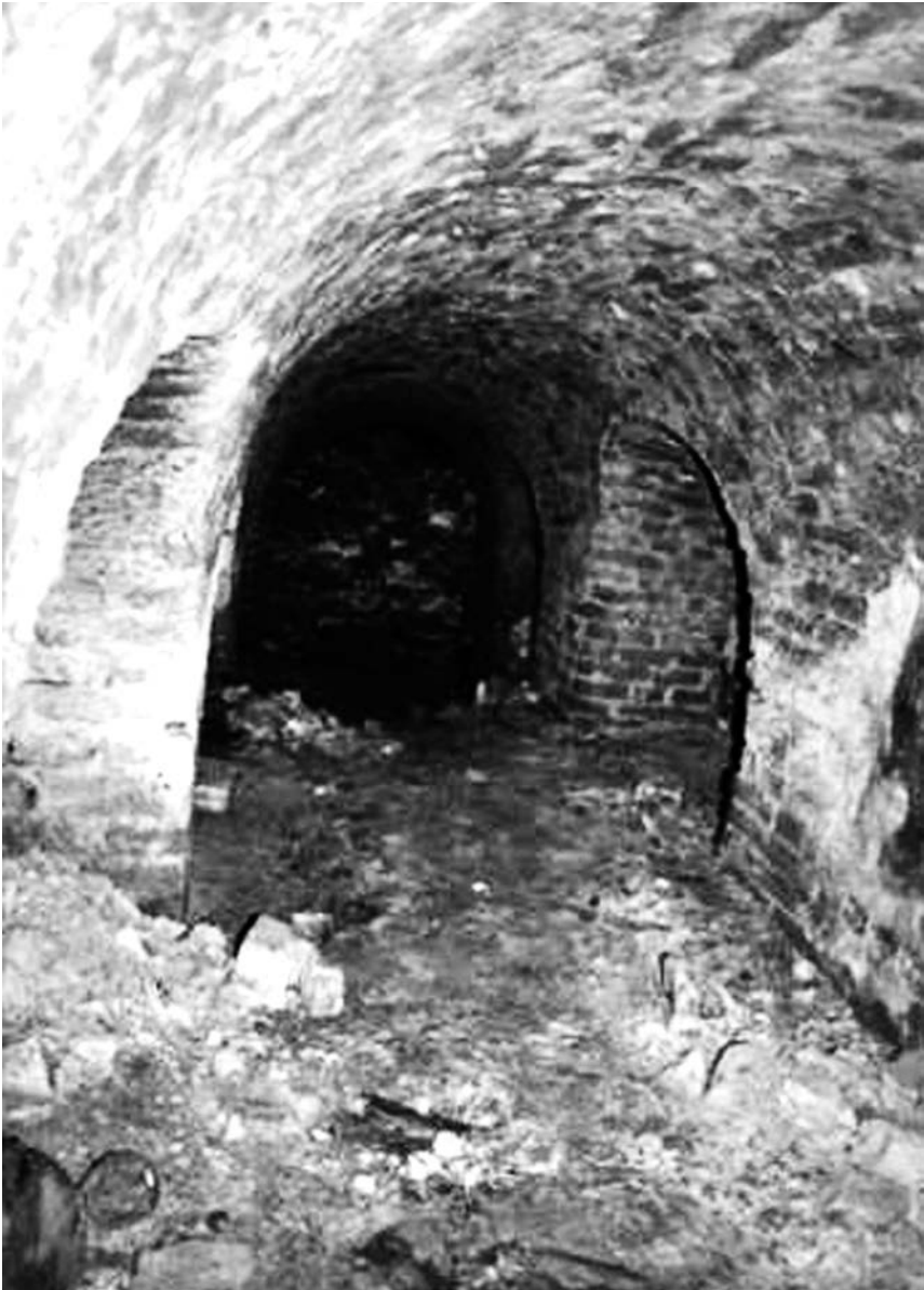
Fot. 7. Ul. Lubelska 2. Dawny klasztor Bazylianów. Dolny poziom lochu obudowany ceglami Fot. S. Gołub
