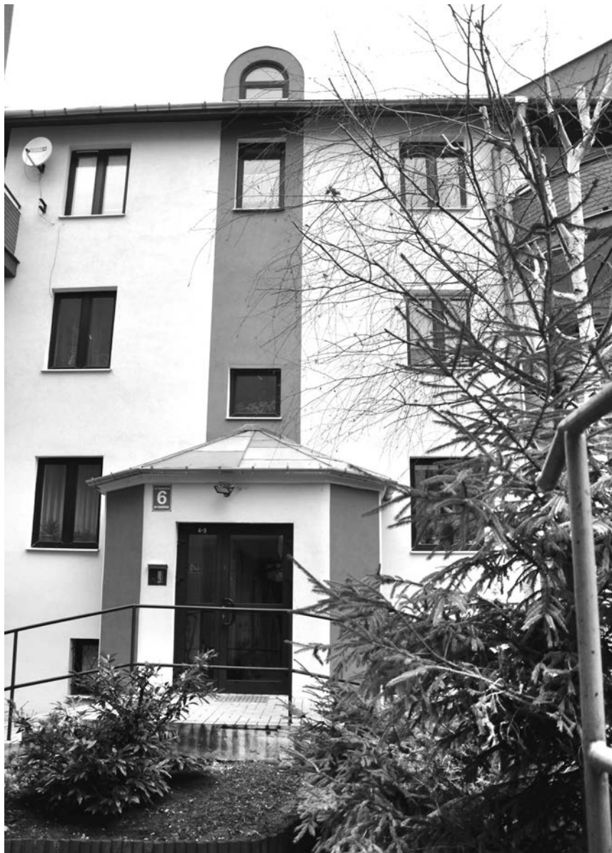
Fot. 4. Ul. Szkolna 6. Wejście do budynku z wykupioną piwnicą, w której znajduje się szyja murowana z zejściem do zabytkowej kopalni kredy
