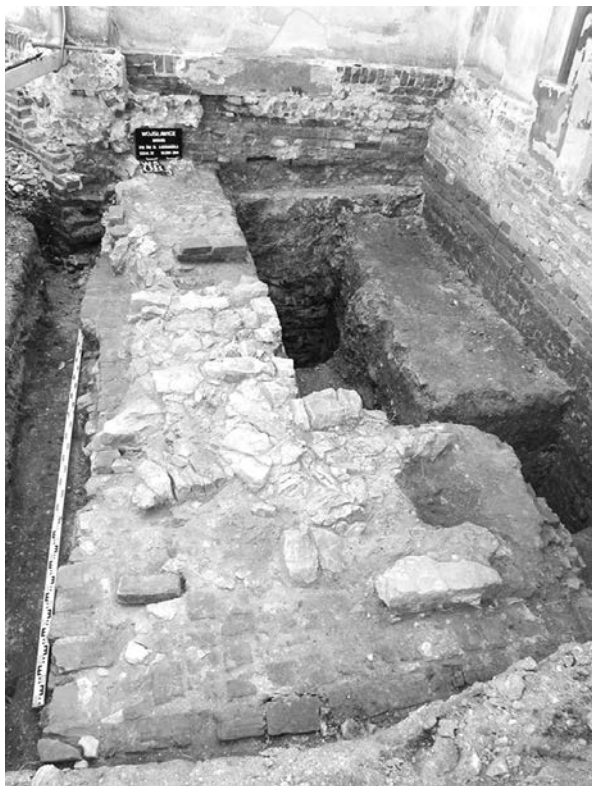
Ryc. 6. Widok na mur narożnikowy dostawiony do ściany prezbiterium, w części zachodniej zniszczony dobudową kaplicy (fot. T. Dzieńkowski)
