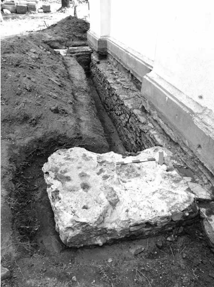
Ryc. 8. Chełm, ul. Sienkiewicza 1. Cerkiew pw. św. Jana Teologa. Lico wschodnie fundamentu pod wschodnią ścianę świątyni oraz pozostałość po fundamentach północnym i południowym niezrealizowanej rozbudowy rozpoczętej w roku 1938. Widok od północy (fot. A. Bronicki)
