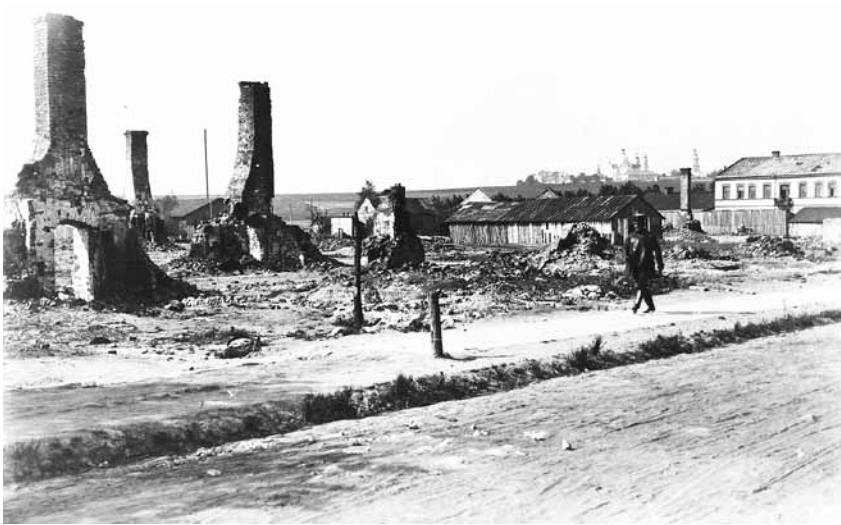
Domy przy ul. Kolejowej 1916 r., karta pocztowa (zbiory ChBP)
