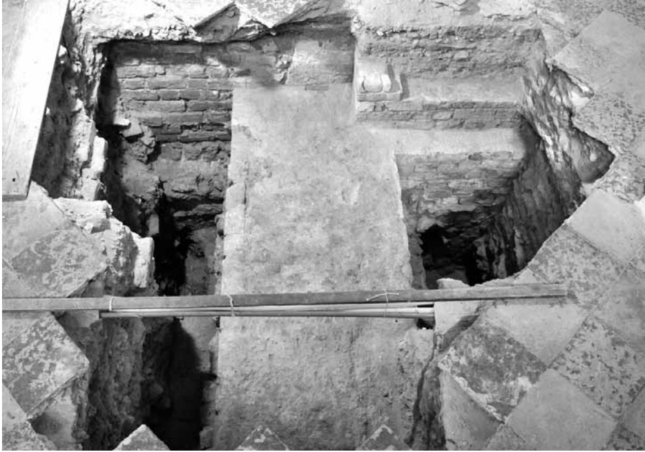
Fot. 7. Wykop 6. Lico wewnętrzne północnej ściany cerkwi z XIII wieku, zbudowanej z cegieł, z przylegającym prostopadłym murem wydzielającym narteks. Autor Grzegorz Zabłocki
