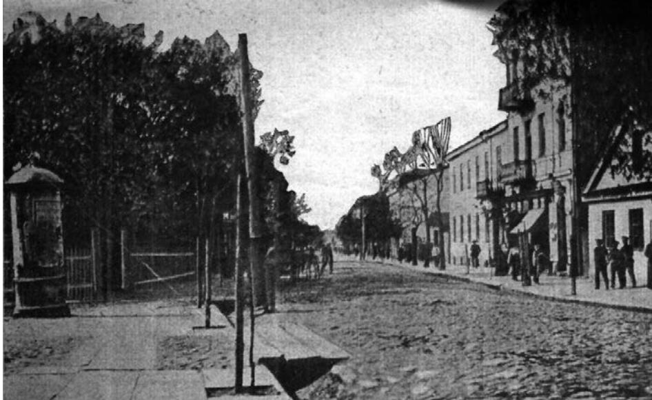
Fragment ulicy Lubelskiej przy skrzyżowaniu z ob. ul. Strażacką, po prawej widoczny parterowy budynek przytułku św. Ducha. Karta pocztowa z ok. 1914 r., kopia w zbiorach WUOZ Delegatura w Chełmie
