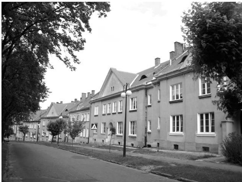
„Dyrekcja” Chełm, ul. Bydgoska. Zdjęcie wykonała B. Litwin
