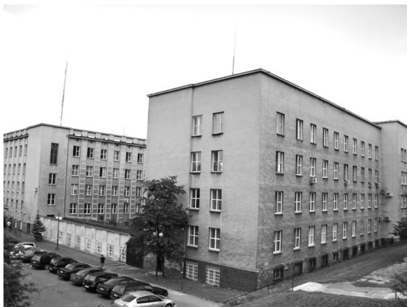
Zachodnia ściana gmachu „Dykcji” (plan litery H). Zdjęcie wykonała B. Litwin
