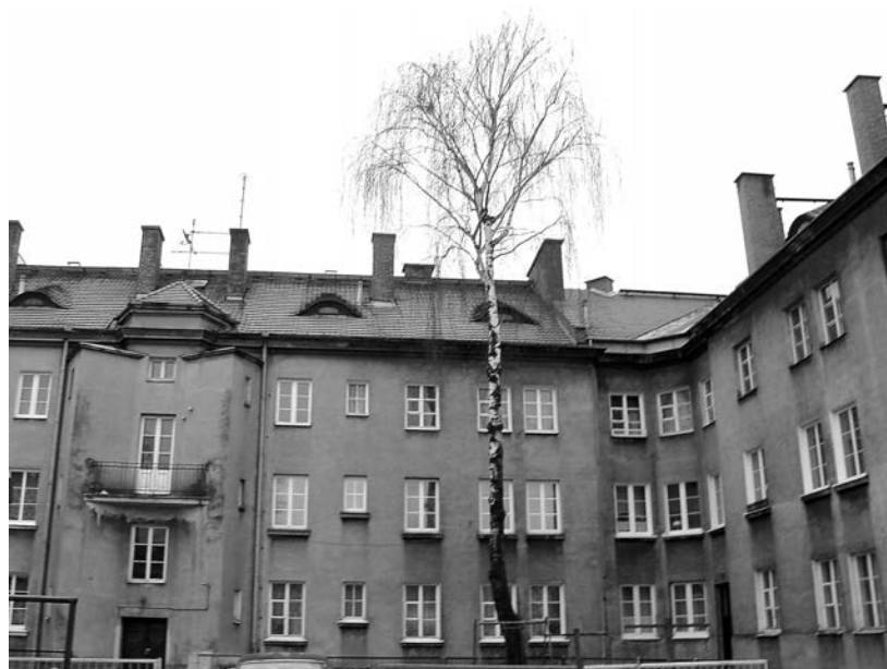
„Dyrekcja” Chelmska dom typu V, wielorodzinny. Zdjęcie wykonała B. Litwin
