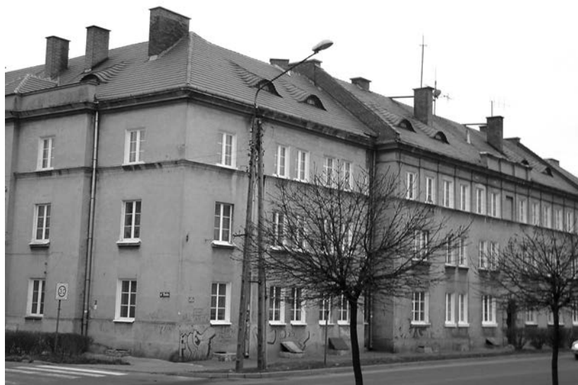
„Dyrekcja” Chelmska dom typu IV, wielorodzinny. Zdjęcie wykonała B. Litwin
