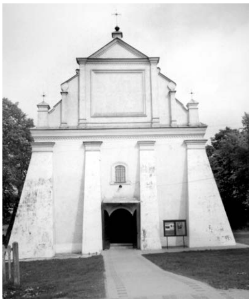
Fot. 1. Fasada kościoła w Podgórzu. Fot. U. Ruszkowska
