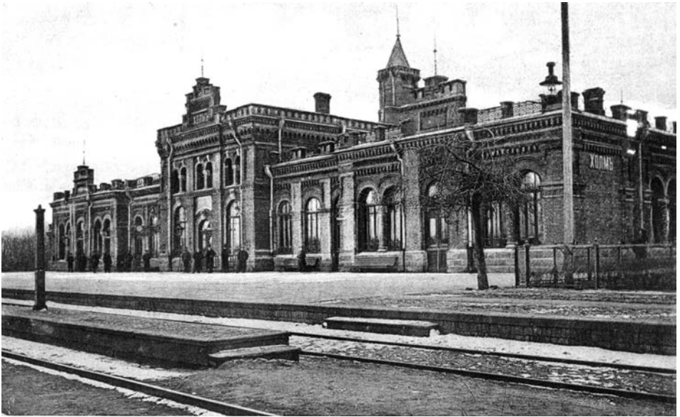
Budynek dworca kolejowego od strony peronów sprzed 1914 r.
