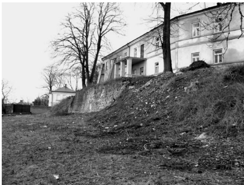
Ryc. 18. Stan obecny ogrodów. Widok pałacu biskupiego od strony najobszerniejszego tarasu. Widoczny potężny mur oporowy podtrzymujący skarpę (fot. J. Kamiński)
